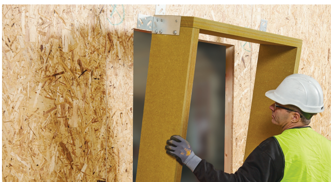
REDAir Link løftes på plass
