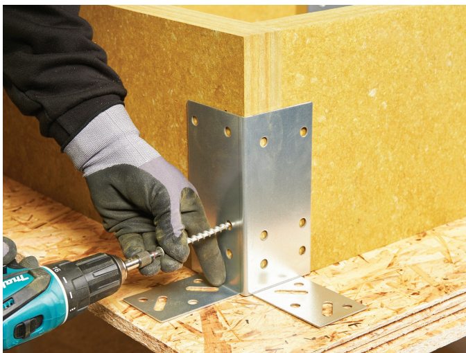
Montering av lang monteringskrue ved hjørnebeslag
