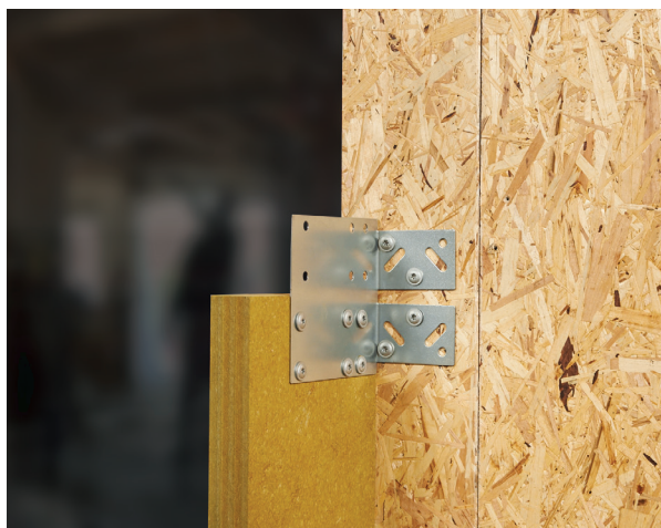
REDAir Link beslagene monteres på bakveggen
