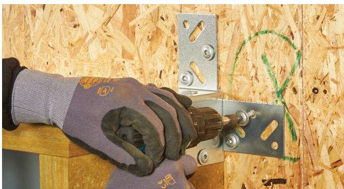
REDAir Link monteres på bakveggen med egnet skrue
