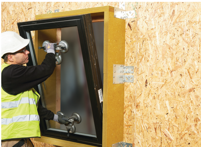
Vinduet løftes på plass i REDAir Link
