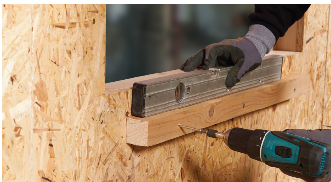
Eksempel på midlertidig lægte til understøttelse af REDAir Link
