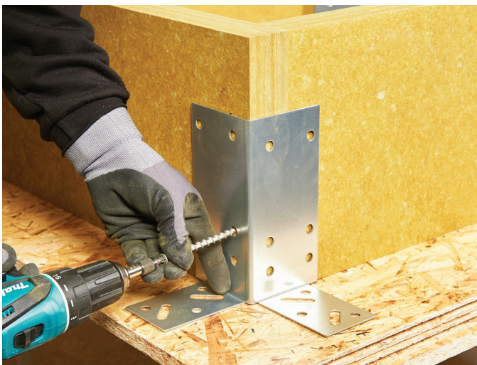
Montage af lang samleskrue ved hjørnebeslag
