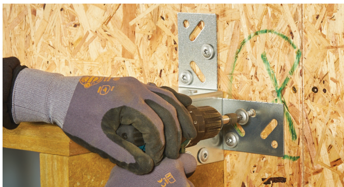
REDAir Link monteres til bagvæggen med egnet skrue
