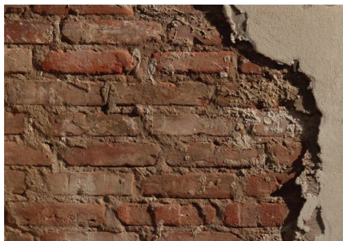
Eksempel på væg som kun med stor indsats kan udbedres, så kravene er opfyldt.
