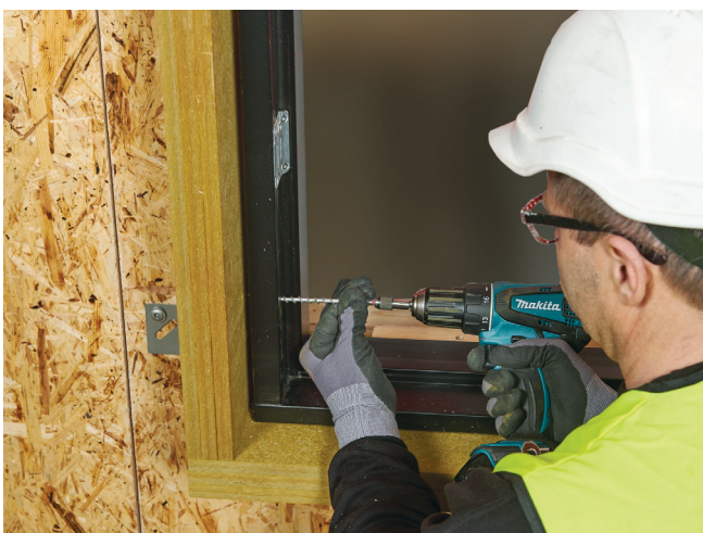
Montage i vindue i REDAir Link med letbetonskrue
