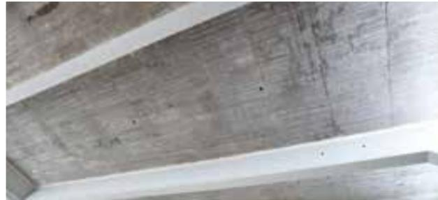
Conlit Steelprotect Board und Steelprotect Board Alu können als Brandschutz für Stahlbetonbauteile im Neubau sowie im Sanierungsbereich verwendet werden.
