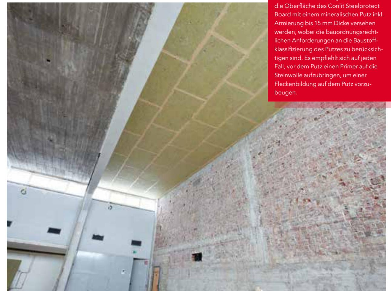
Falls erforderlich oder gewünscht, darf die Oberfläche des Conlit Steelprotect Board mit einem mineralischen Putz inkl. Armierung bis 15 mm Dicke versehen werden, wobei die bauordnungsrechtlichen Anforderungen an die Baustoffklassifizierung des Putzes zu berücksichtigen sind. Es empfiehlt sich auf jeden Fall, vor dem Putz einen Primer auf die Steinwolle aufzubringen, um einer Fleckenbildung auf dem Putz vorzubeugen.
