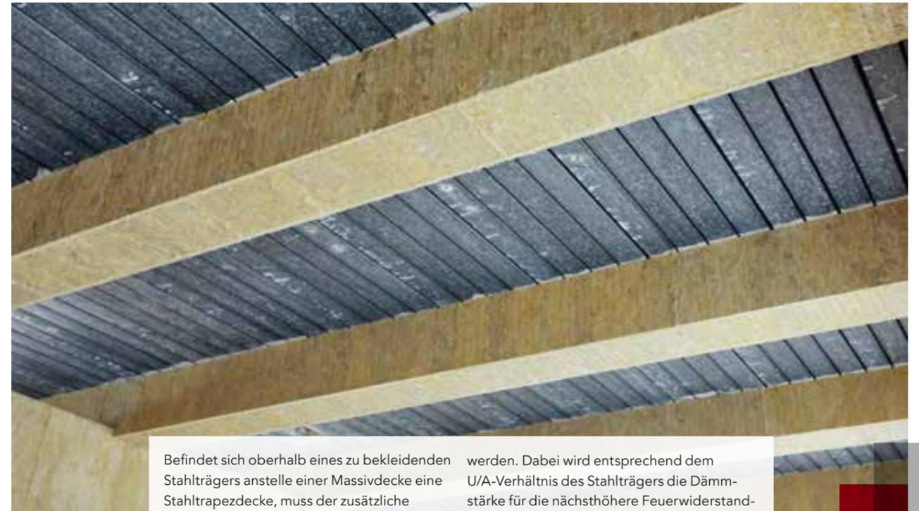
Befindet sich oberhalb eines zu bekleidenden Stahlträgers anstelle einer Massivdecke eine Stahltrapezdecke, muss der zusätzliche Wärmeeintrag durch ungeschützte Bereiche am oberen Trägerflansch berücksichtigt werden. Die Notwendigkeit zusätzlicher konstruktiver Maßnahmen ist dabei vom weiteren Deckenaufbau abhängig. Unterschieden wird dabei zwischen Trapezblechdecken mit bzw. ohne Wärmedämmung und solchen mit Aufbeton (Verbunddecken).
