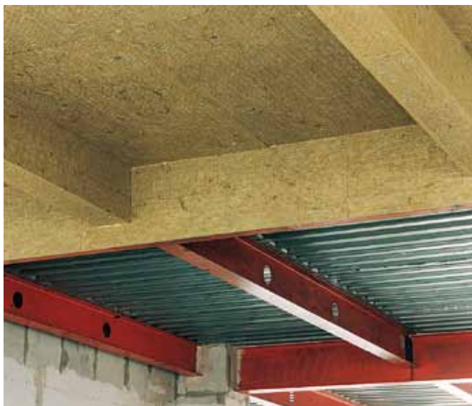
Exemple d'illustration de protection de poutres
