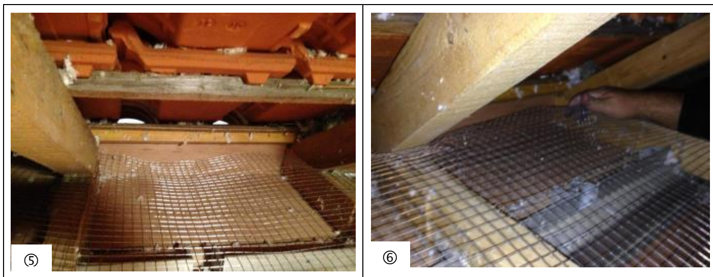
Figure 17 : Le grillage épous le contour de la structure (gauche) et il est recourbé à la main en partie basse (droite)
