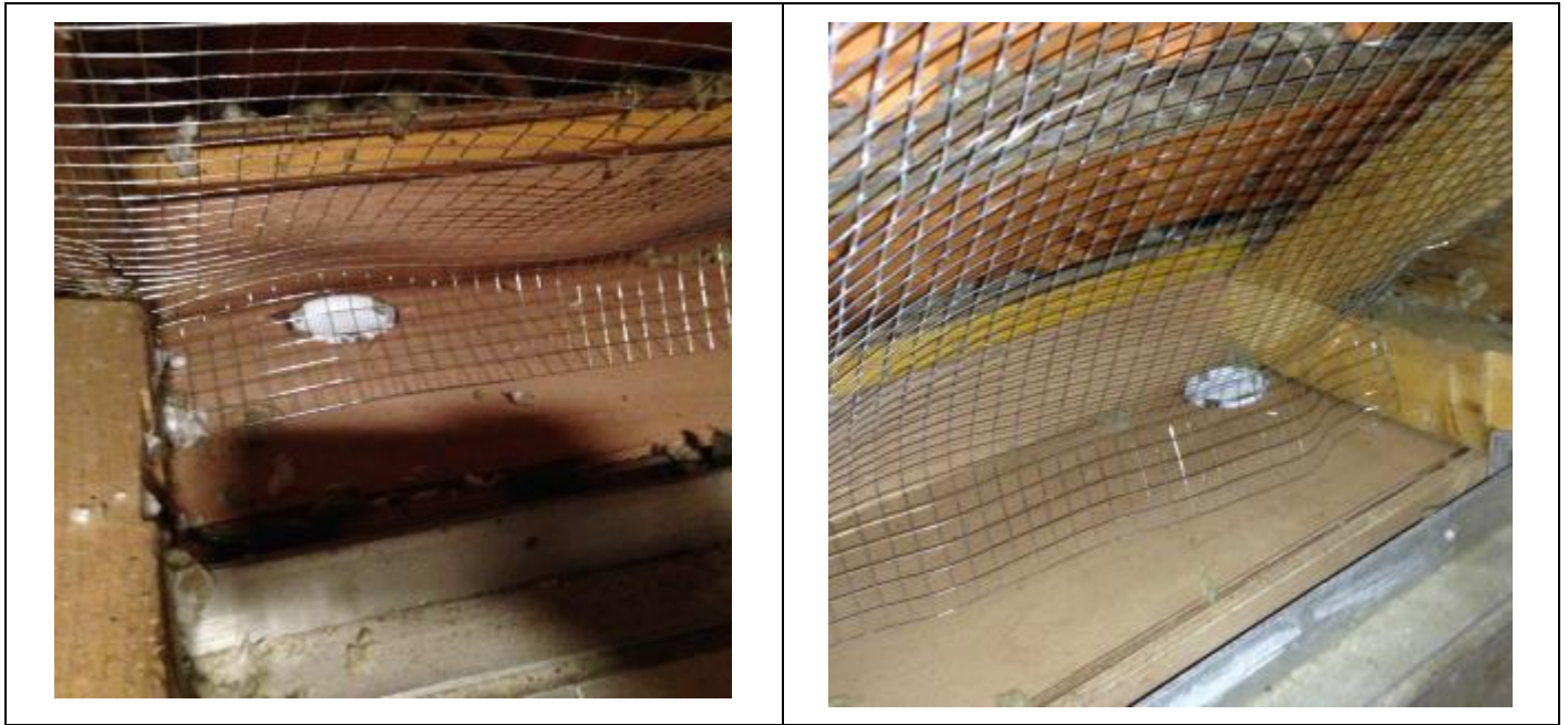
Figure 18 : Vue de la partie basse du grillage installé, avec les bouches d'entrée d'air dégagées
