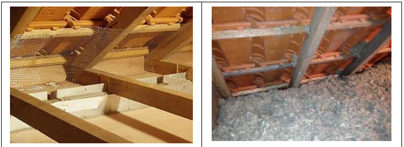
Figure 19 : Vue d'ensemble du grillage installé, avant (gauche) et après (droite) soufflage de la laine de roche
