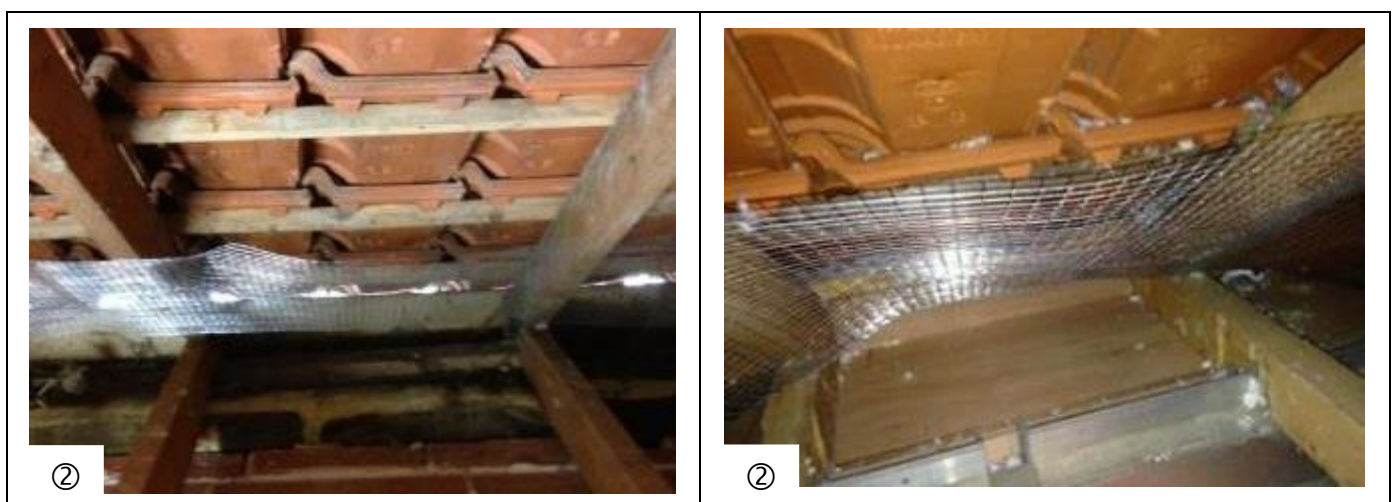
Figure 10 : Positionnement du grillage dans un comble à faible pente, avec entrée d'air par le galbe des tuiles et présence d'entretoise et de panne sablière (gauche) et planche de rive (droite) en partie basse de la rive
