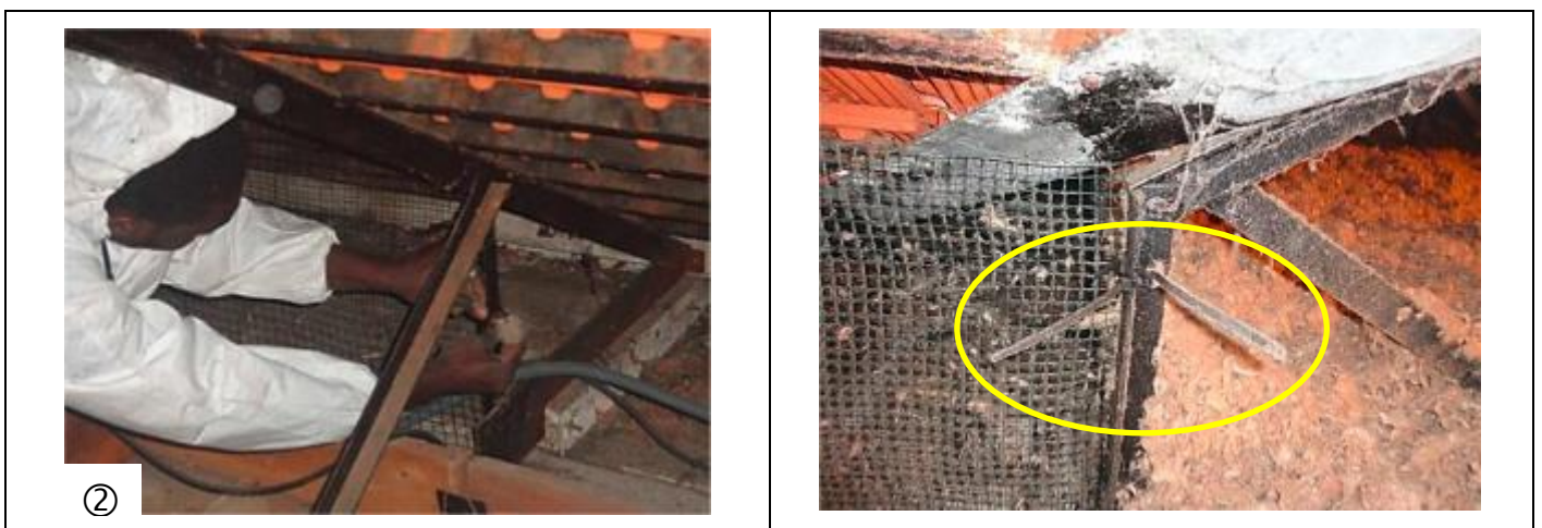
Figure 6 : Mise en œuvre du grillage sur les contrefiches (gauche) à l'aide de colliers plastiques (détail à droite)
