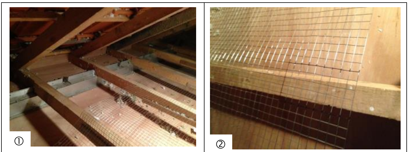
Figure 15 : Marquage au feutre du grillage selon la distance entre contrefiches
